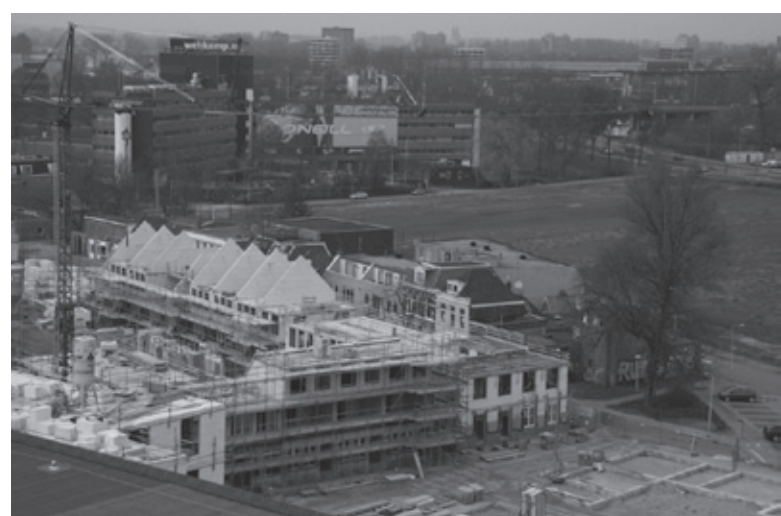
Vanaf bovenaf is de voortgang van de Feniks in goed te zien. (fotograaf Harry ten Klooster)
